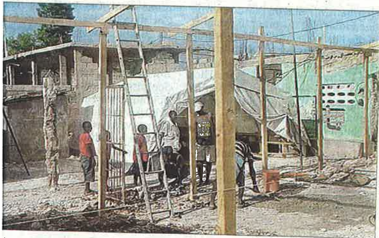
Barbarer Baufortschritt: Anstelle der zerstörten Schule im vom Erdbeben heimgesuchten Katastrophengebiet entsteht ein fester Hangar.
